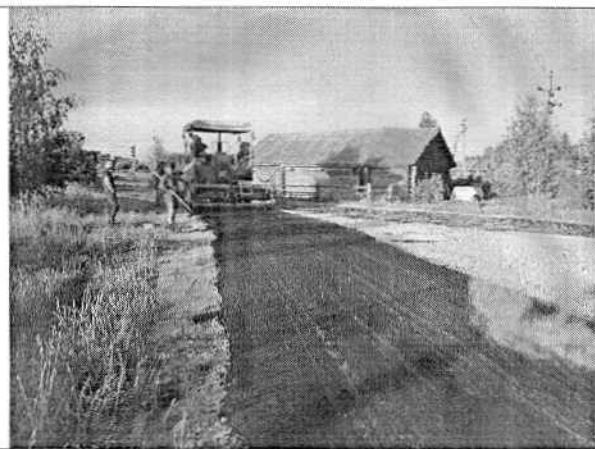
Фото выполнения работ по благоустройству адрес объекта: д.Ченцы, ул.Молодежная 1, 2
